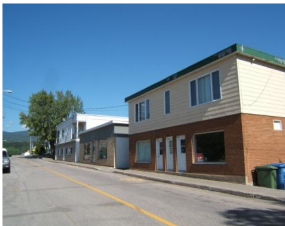
Photo 1 : Rez-de-chaussée commercial transformé en logement
