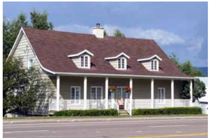
Maison sise au 23, boulevard Notre-Dame.
