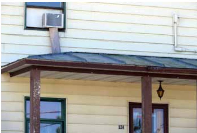
Auvent recouvert de tôle pincée de la maison sise au 124, rue Lapointe.
