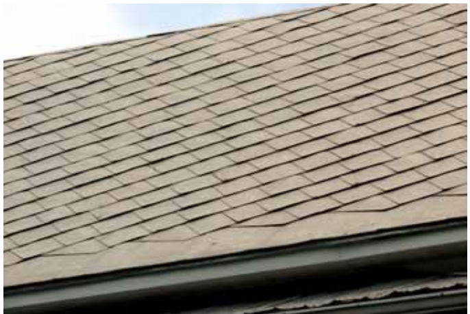
Revêtement en tôle canadienne de la maison sise au 1, côte Saint-Charles.
