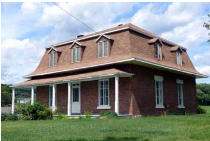
Maison de ferme sise au 49, chemin des Lacs.
