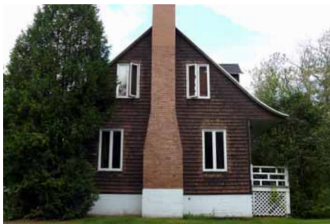
Cheminée de brique de la maison de compagnie sise au 107, rue Maisonneuve.
