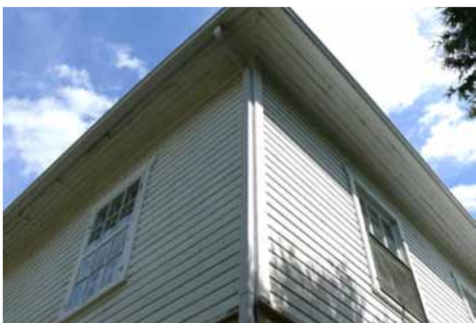
Revêtement en planches de bois horizontales de la maison sise au 9, rue de la Donohue.
