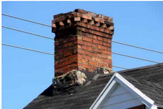
Cheminée de brique de la maison Lapointe sise au 74, rue Lapointe.
