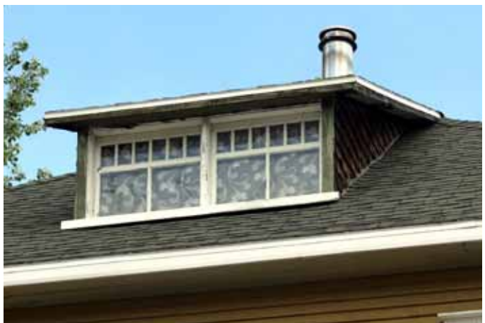
Lucarne en appentis observable sur la maison sise au 1, rue des Vieux-Moulins.
