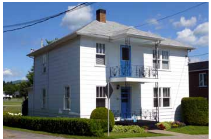
Parement en amiante-ciment d'une maison sise au 5, rue des Érables.
