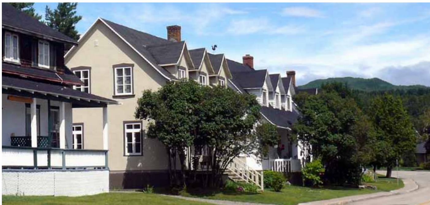
Cet ensemble de maisons érigées dans les années 1927-1929 pour loger les employés spécialisés de la compagnie Murray Bay Pulp & Paper est visible à l'extrémité sud de la rue Maisonneuve.
