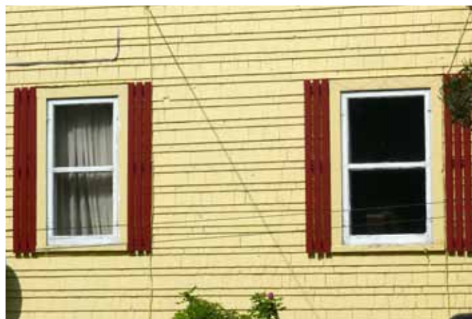
Revêtement de bardeaux de bois de la maison sise au 14, rue des Vieux-Moulins.
