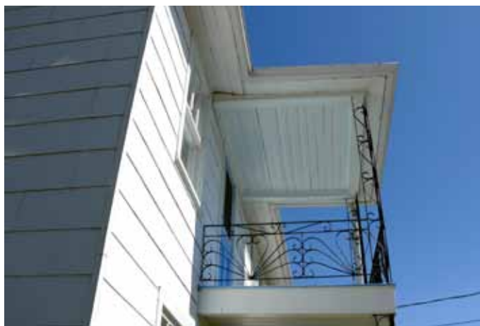
Garde-corps en fer ceinturant le balcon de la maison sise au 5, rue des Érables.
