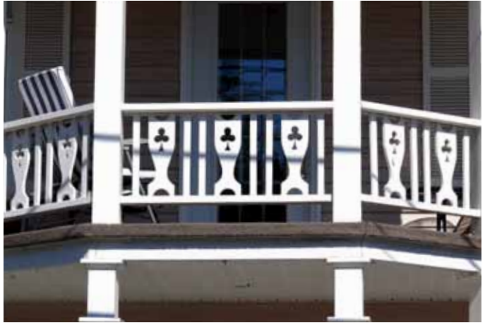
Garde-corps en bois ceinturant le balcon de la maison sise au 9, rue Monseigneur-Savard.
