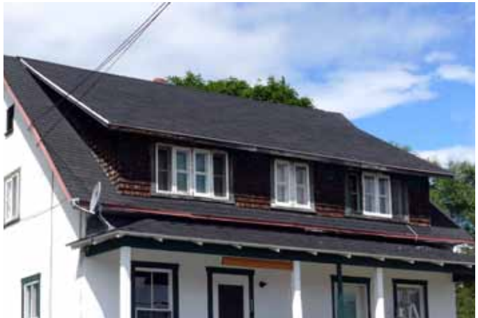
Lucarne en appentis visible sur la maison sise au 12, rue Maisonneuve.
