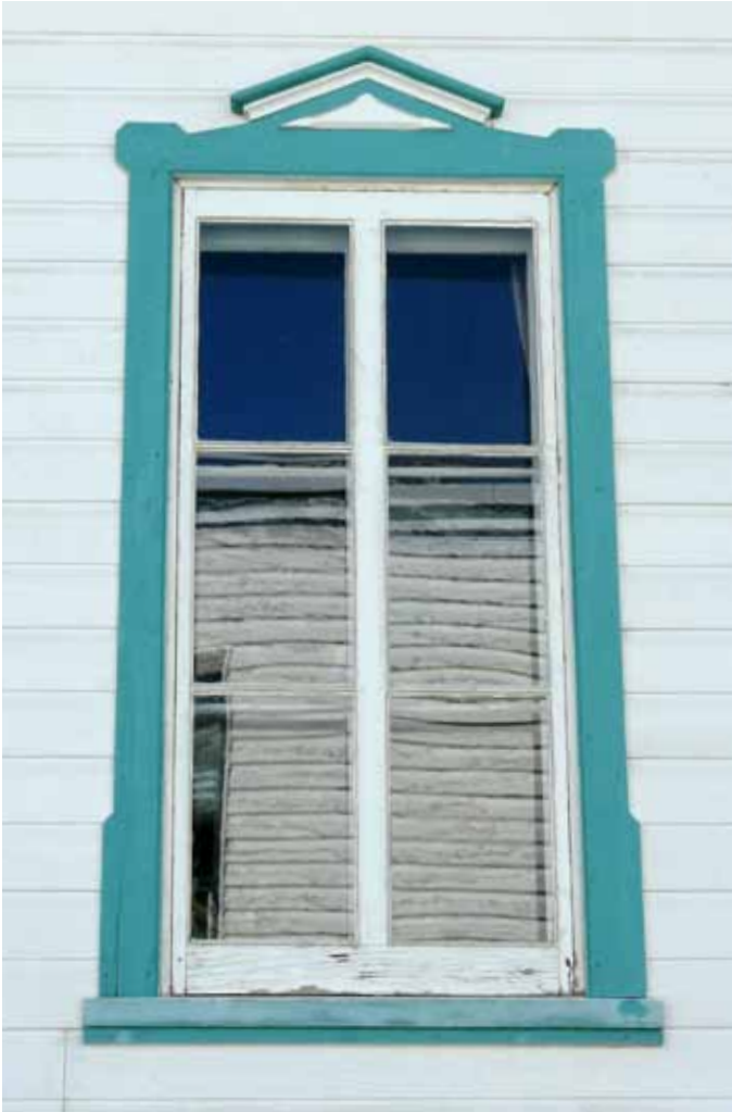
Ouverture avec une fenêtre à battants à grands carreaux complétée par une contre-fenêtre servant contre le froid. Cette fenêtre se trouve sur la maison sise au 59, rue Lapointe.
