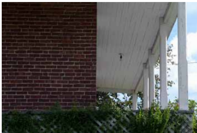
Revêtement en brique de la maison sise au 49, chemin des Lacs.
