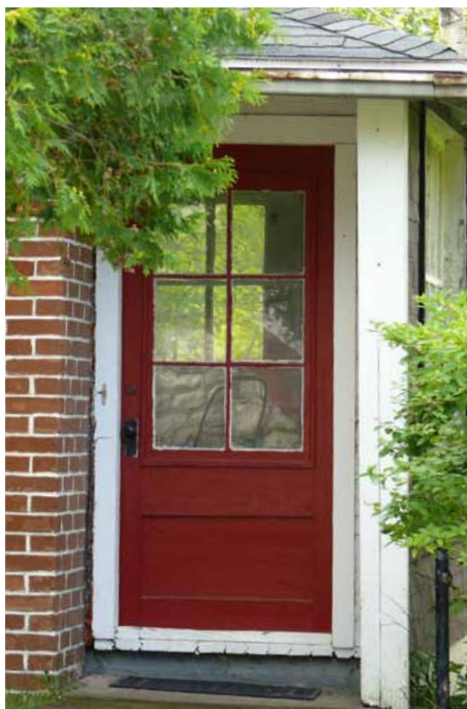
Porte à panneaux en bois avec vitrage de la maison sise au 14, rue des Vieux-Moulins.
