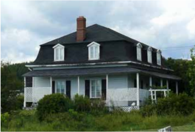
Maison de ferme sise au 36, chemin des Lacs.
