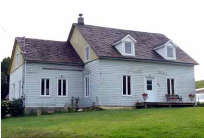
Maison de ferme sise au 80, chemin des Lacs.
