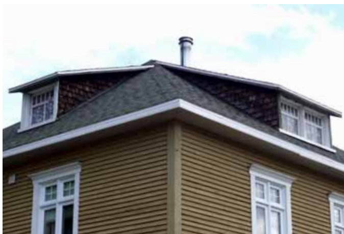
Revêtement en planches de bois verticales de la maison sise au 1, rue des Vieux-Moulins.
