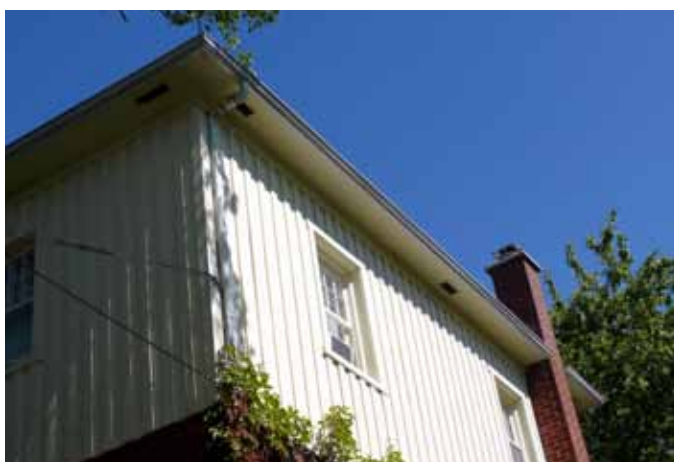
Revêtement en planches de bois verticales de la maison sise au 54, rue Saint-Philippe.
