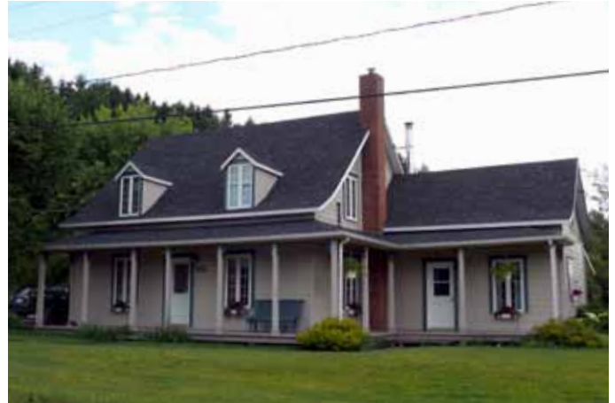
Maison de ferme sise au 108, chemin des Lacs.
