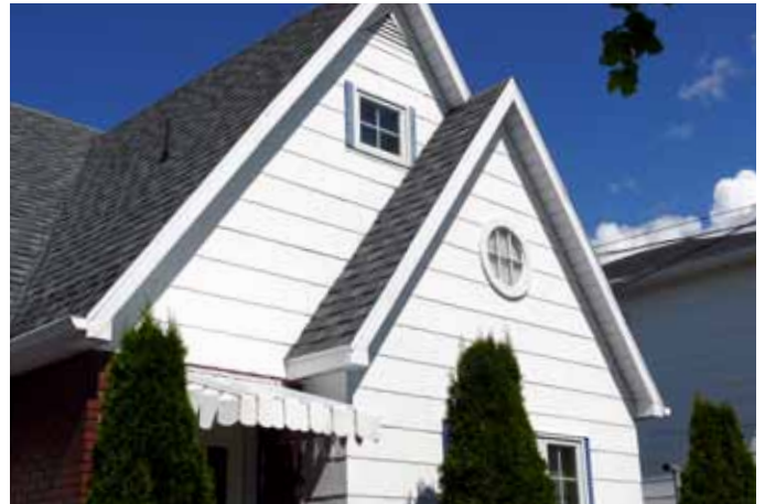
Parement en amiante-ciment d'une maison sise au 33, rue des Érables.
