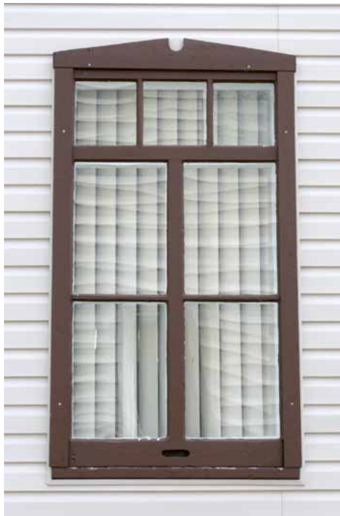
Modèle de fenêtres à battants à grands carreaux surmonté d'une imposte tel qu'on en retrouvait à maintes reprises, autrefois à Clermont. Cette fenêtre se trouve sur la maison sise au 3, rue de la Donohue.
