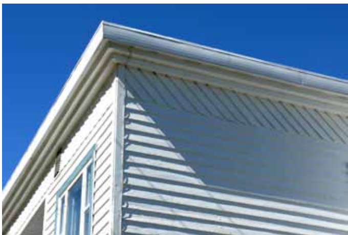
Revêtement en planches de bois horizontales de la maison sise au 125, rue Lapointe.
