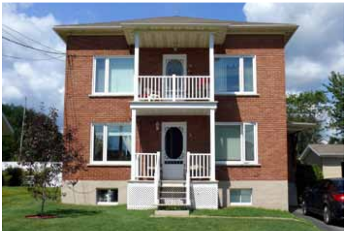
Maison sise au 4, rue Forget.
