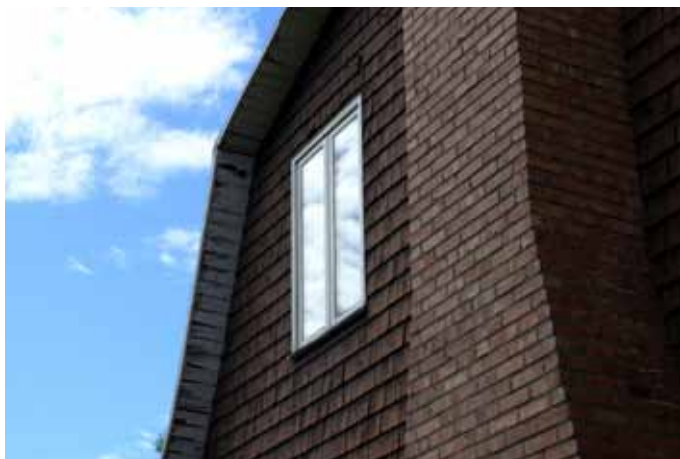
Revêtement de bardeaux de bois de la maison sise au 103, rue Maisonneuve.
