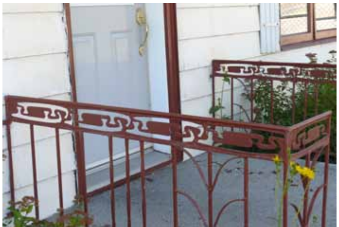
Garde-corps constitué de lames de patins, ornant la maison sise au 20, rue Saint-Philippe.
